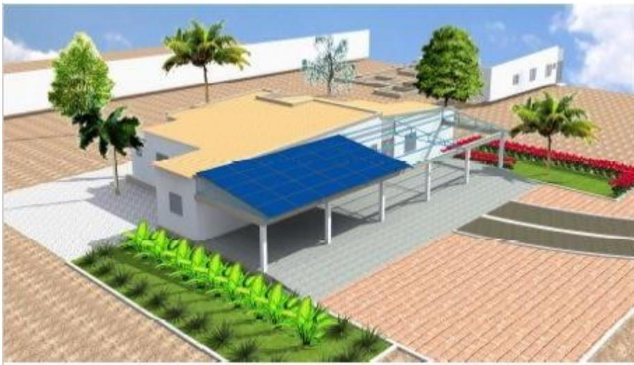
Il primo lavoro che finanzieremo nel 2018 sarà proprio quello di installare l'impianto fotovoltaico che, in questa prima fase del progetto, è dotato di 72 pannelli fotovoltaici per complessivi 17 kw, e 24 batterie per 19.200Ah. A questo aggiungeremo un generatore per far fronte ad eventuali sovraccarichi notturni delle batterie o a giornate di poco sole.
