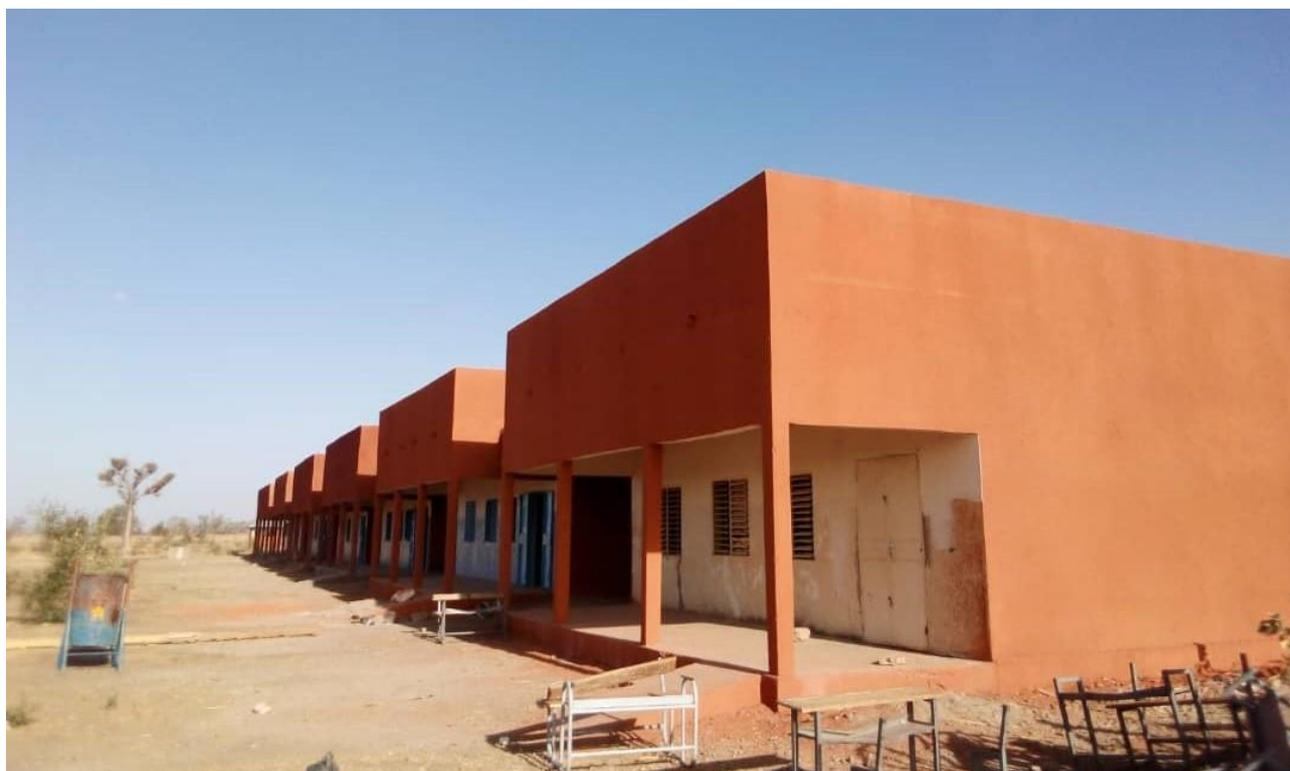
A gennaio sono terminati anche gli interventi di rifacimento del tetto delle ultime due classi primarie: rialzati per migliorare l'areazione degli ambienti e aumentare l'isolamento del soffitto.
