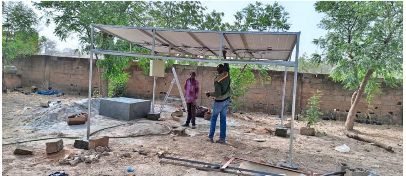
Subito dopo la costruzione di un pergolato su cui installare i pannelli solari con cui fornire energia elettrica alla pompa
