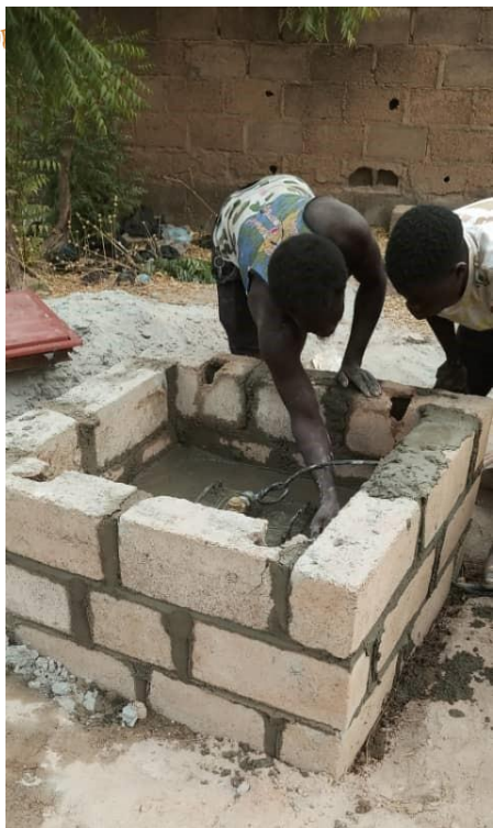
Poi la posa delle tubature con cui portare l'acqua alla cisterna
