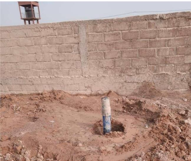
E al mattino del giorno dopo, il *forage* era completato con i suoi 70 metri di tubi che penetrano giù sotto terra fino a raggiungere la falda.
