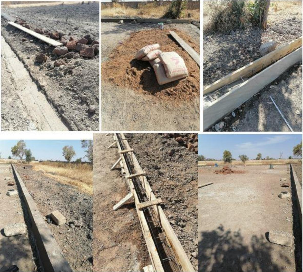
Il terreno è stato poi scavato ad una profondità di 20 cm, su cui è stato posato uno strato di materiali di spessore variabile a seconda della natura del terreno e delle necessità. E' seguito il riempimento con acqua e quindi la stesura della pavimentazione di 15 cm di cemento rinforzata con tubi in acciaio da 8mm.
