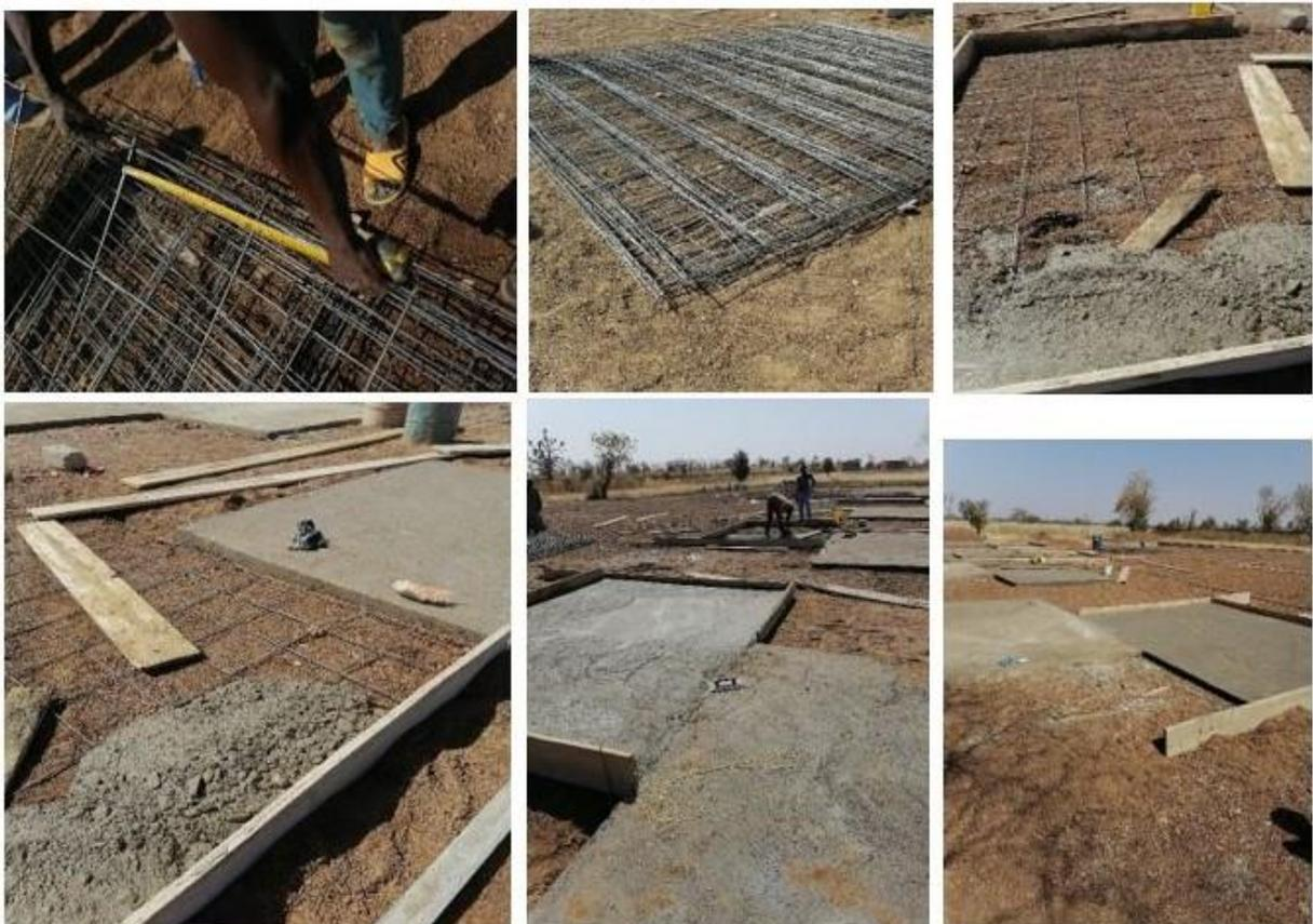
La pavimentazione è stata realizzata ad isole in modo da minimizzare il deterioramento. Le piogge torrenziali dell'estate possono allagare il terreno per giorni e giorni.
