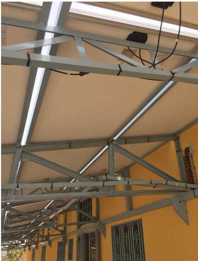
E questo è il lavoro finito: 72 pannelli da 235 watt immagazzineranno energia per tutto il CSPA, una capacità che dovrebbe essere sufficiente almeno nella fase iniziale. Più avanti, quando il Centro sarà completato e operativo, valuteremo se aumentare questa capacità.
