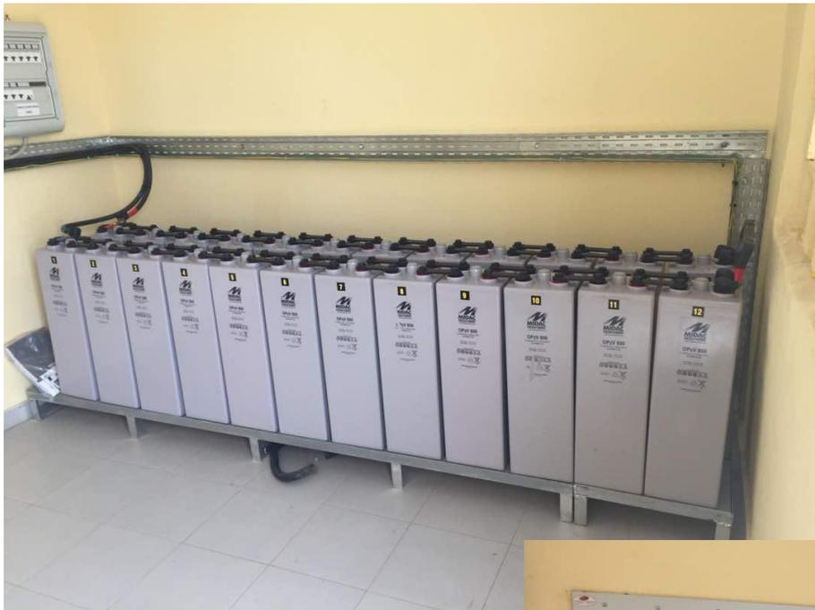
E questa è la sala tecnica con 24 batterie da 800Ampere/ora che dovrebbero assicurare un'adeguata copertura delle ore senza sole.
