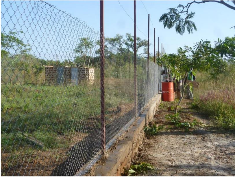
dell'area per dare forza e consistenza alla struttura. Una colata di cemento ha fissato la rete metallica ai mattoni dando resistenza e robustezza a tutta la struttura.
